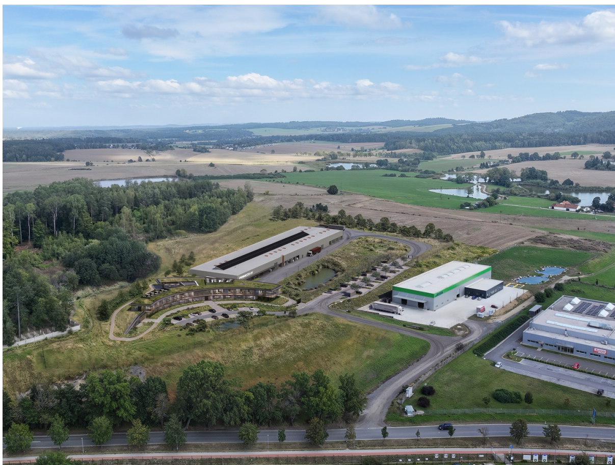
Vizualizace stavby nového výrobního závodu 2026 – 2028 v Písku.
